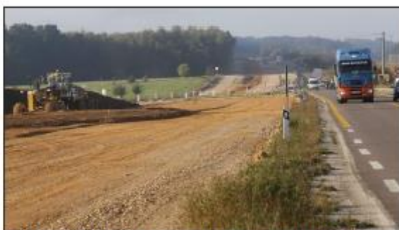
■ Sur la RN 57 au sud de Rioz, il reste environ un an de travaux avant la mise en service de la portion They/Voray-sur-l'Ognon.
