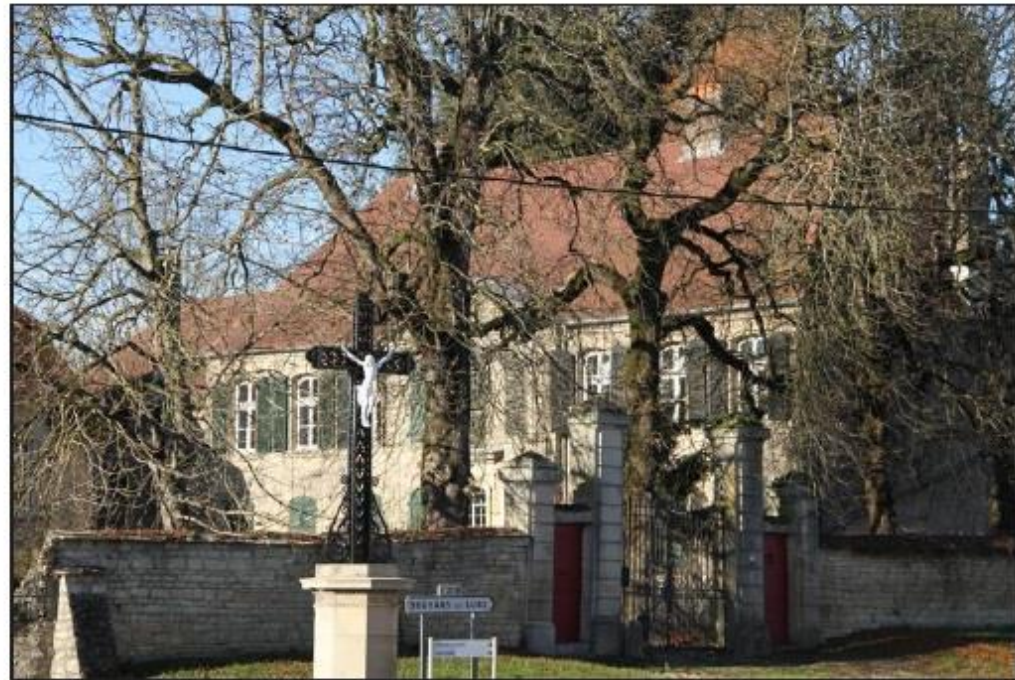
■ Il y a 400 mètres carrés habitables au château.
